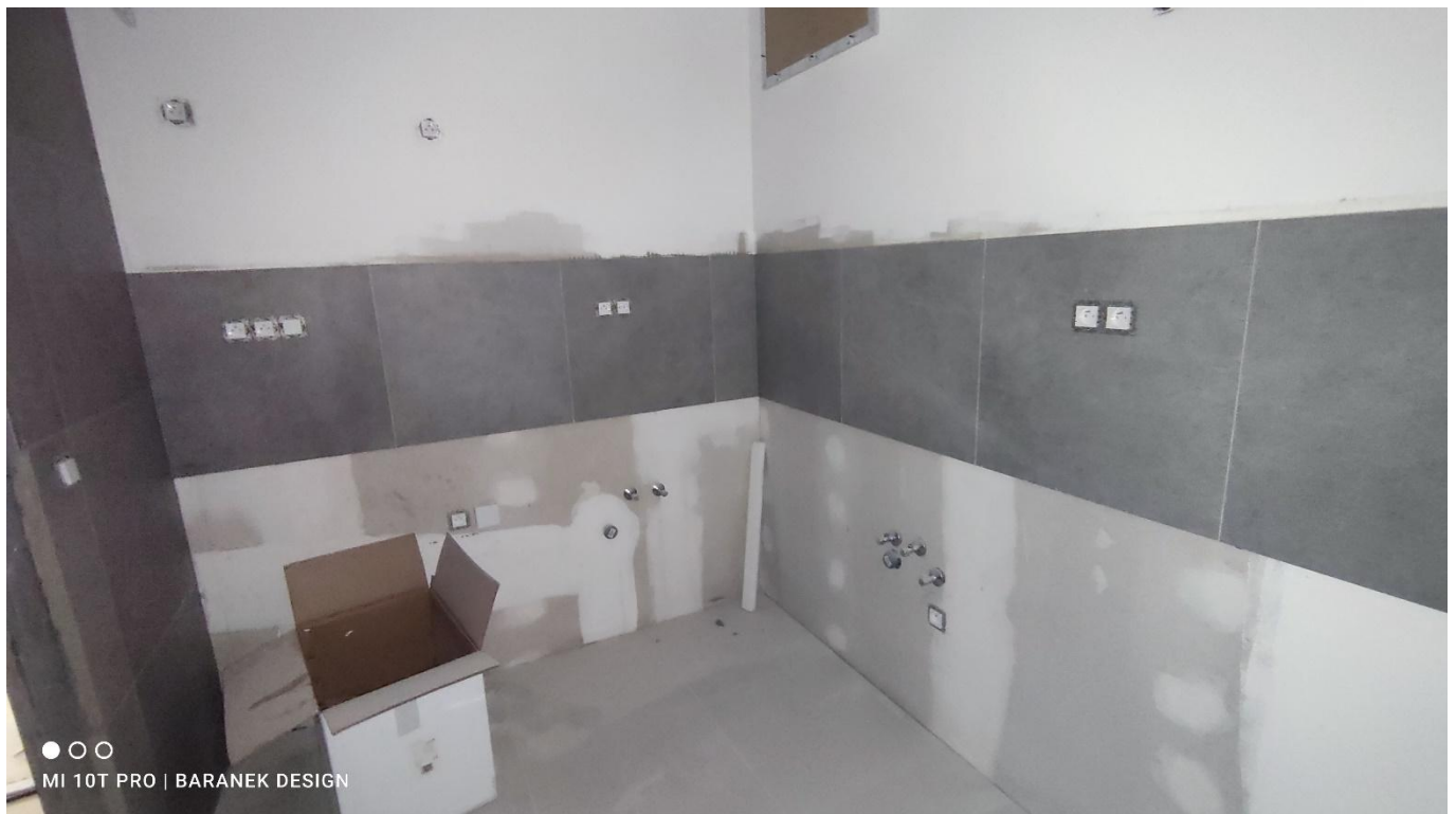
FOTO 23 – Prostory jednotlivých ubytovacích jednotek
