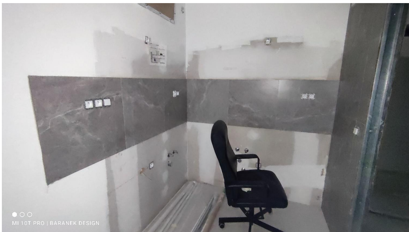
FOTO 26 – Prostory jednotlivých ubytovacích jednotek
