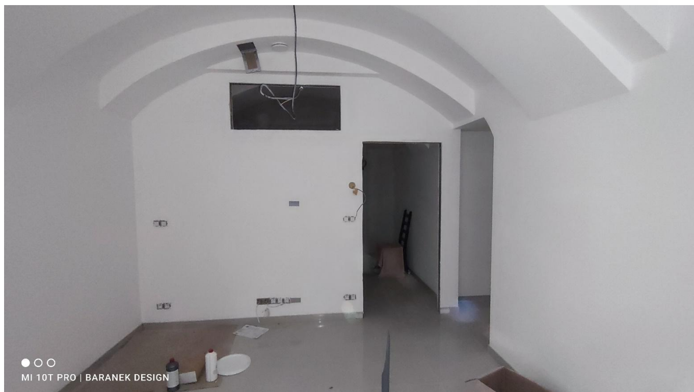
FOTO 20 – Prostory jednotlivých ubytovacích jednotek se světlíky
