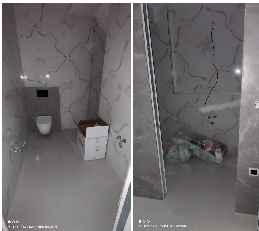
FOTO 21, 22 – Prostory jednotlivých ubytovacích jednotek
